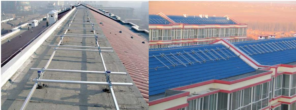
**附图五 整栋楼顶热水器就位桥架照片**
