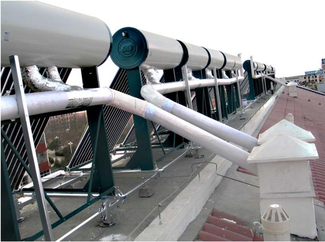
附图六 住宅集中安装分户使用太阳能热水系统背面效果
