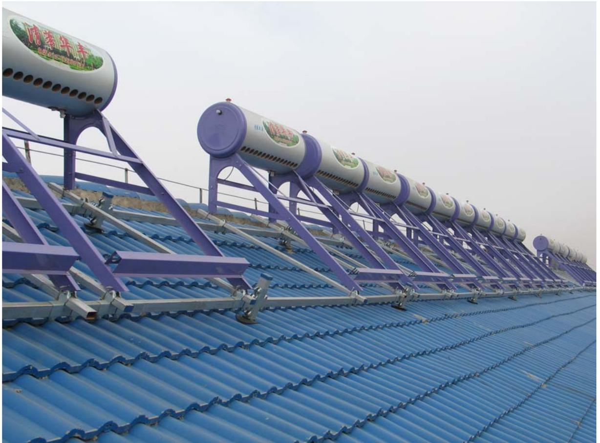
附图七 住宅集中安装分户使用太阳能热水系统正面效果
